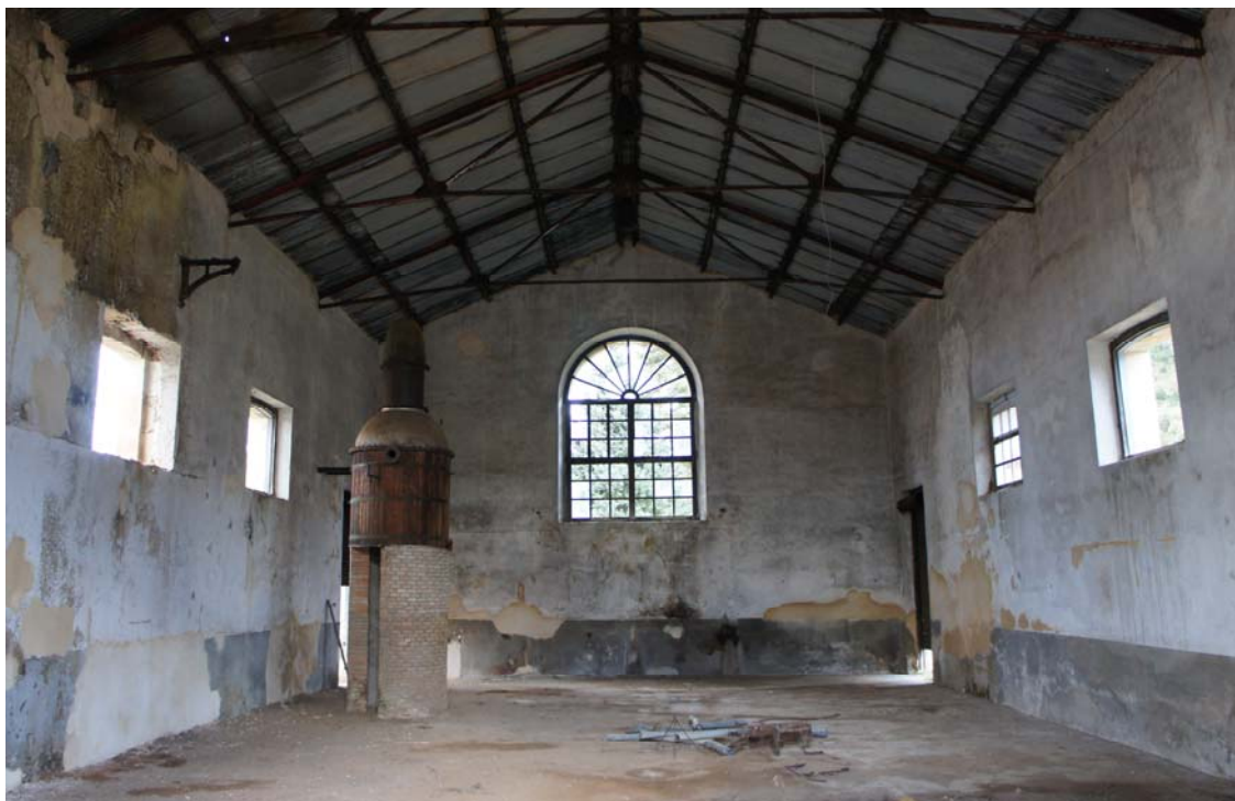
Interior de la nave principal.
