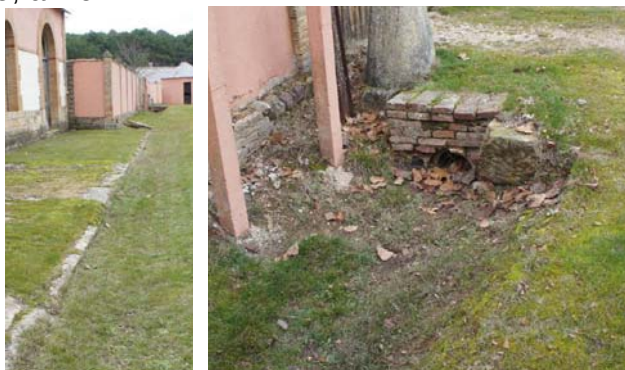
Rigolas y otras conducciones de aguas pluviales.
